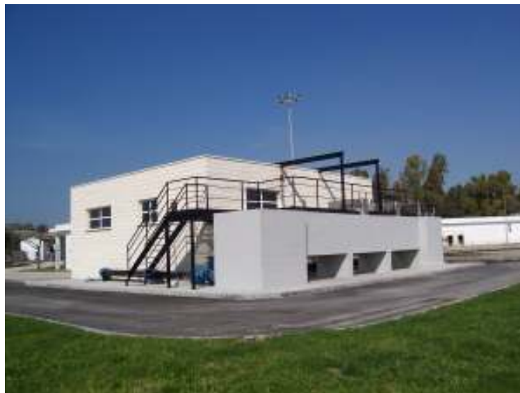
Vista general del edificio del terciario y el canal ultravioleta.
